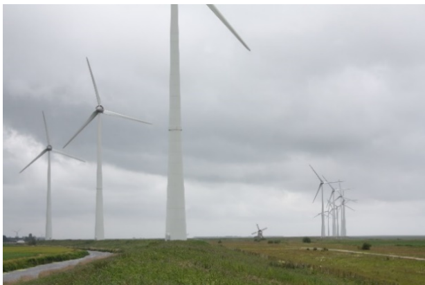
Figuur 14. Klassieke windmolen de Goliath in de Eemshaven tussen moderne windturbines die vaak groot zijn; een tweemaal zo grote windturbine levert 30% meer energie op.
