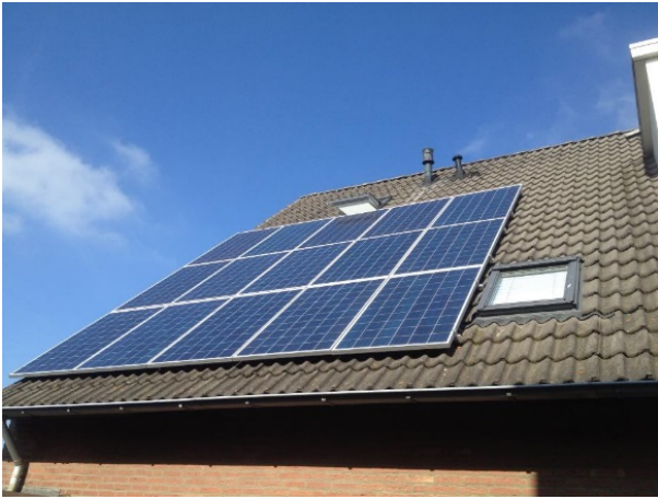
Figuur 15. Zonnepanelen voorzien van een speciale DSM-coating op het dak van een huis in Sittard.
