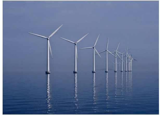
Figuur 16. Windturbinepark Middelgrunden in zee (de Sont) bij het Deense Øresund. Afstand tussen twee windturbines: 180 meter. Foto: Kim Hansen.
